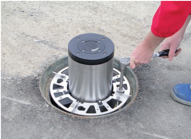
Führungskäfig mit „Werkzeug Verstemmen“ fest positionieren
