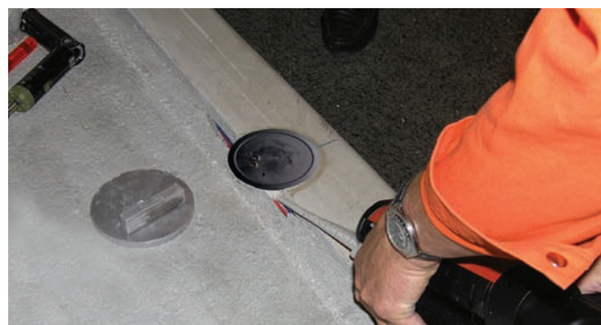
Nut wird mit Dicht- und Klebmasse abgedichtet
