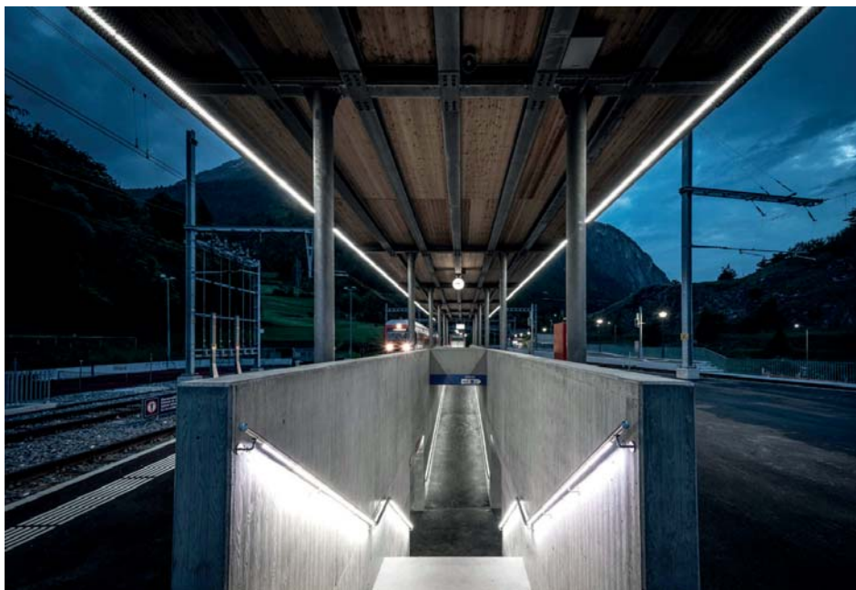
Bahnhof Sembrancher: Übergang Deckenlösung zu Handlauf – harmonisch aus einem Guss.
