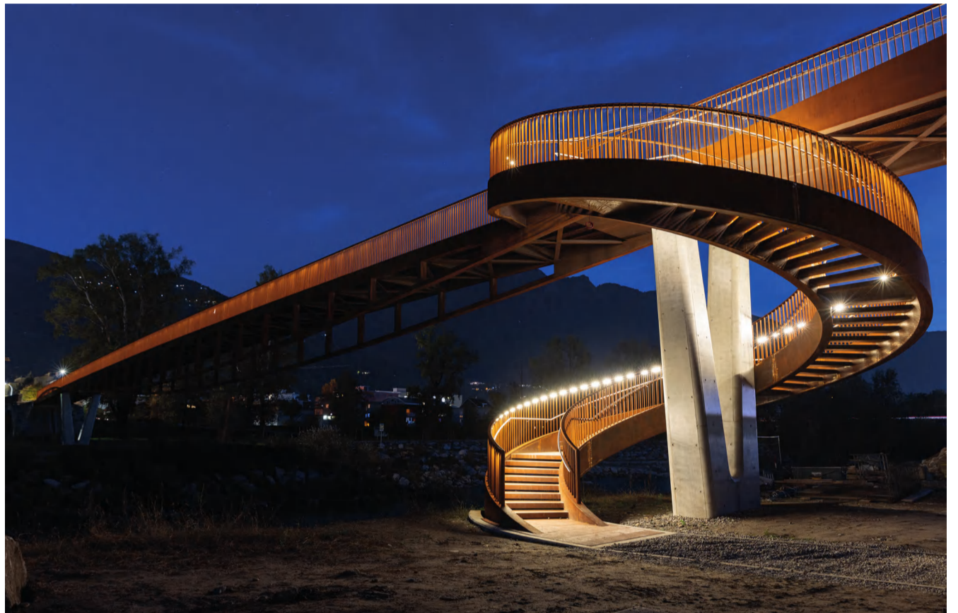
Passarella Torretta Bellinzona
