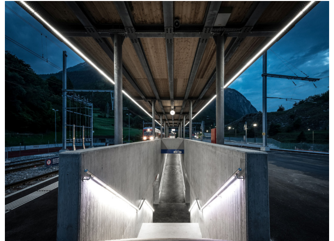
Stazione ferroviaria Sembrancher (parete: LaneLED WALL, tromba delle scale: LaneLED INOX42)
